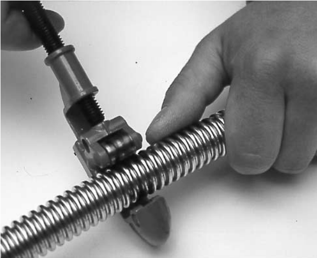
Bild 4 Edelstahlwellschlauch auf gewünschte Länge in einem Wellental plan mit einem Rohrschneider oder einer Eisensäge abschneiden. Zum Schutz der Hände und der Dichtungen Grate entfernen.
